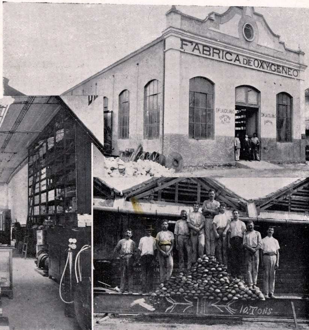
Vista da Fabrica no Rio de Janeiro Duas vigas de 0,50 soldadas pelo processo Oxy-Acetyleno
